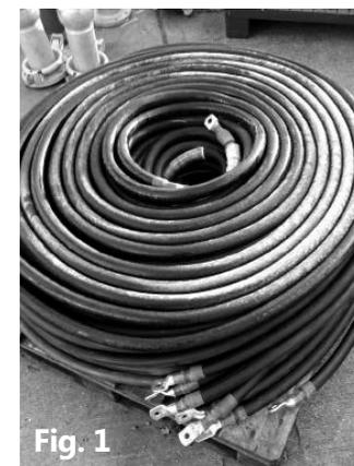
Le point d'entrée du câble est positionné à côté du panneau de commande principal. Câbles de 4 x 95 mm<sup>2</sup> sont requis pour les connexions au panneau électrique principale.
